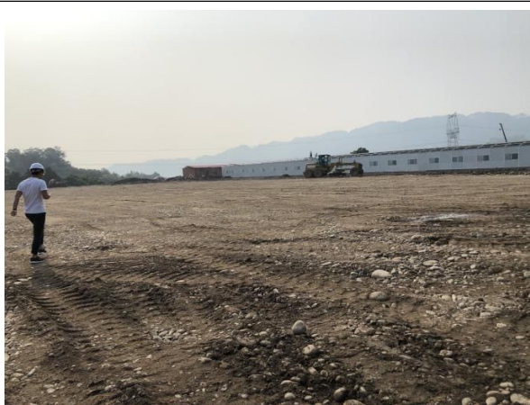
左岸砂石拌和系统营地场地平整
