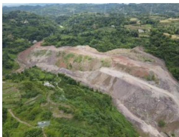
斑竹村弃渣场挡护、表土剥离、排水沟、临时绿化等水保措施
