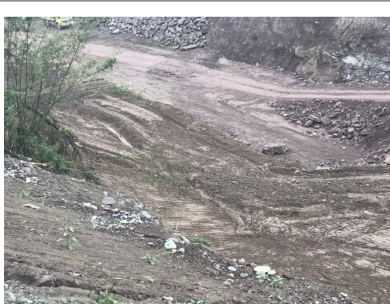
X144 改线 (K0+900) 临时排水沟
