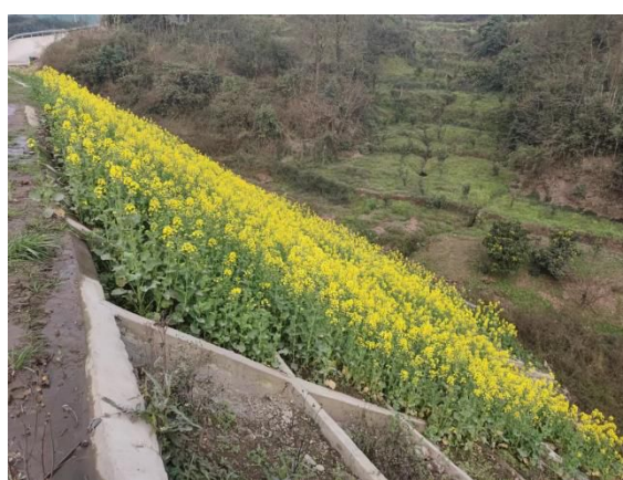
左岸 X144 县道边坡栅格护坡、绿化
