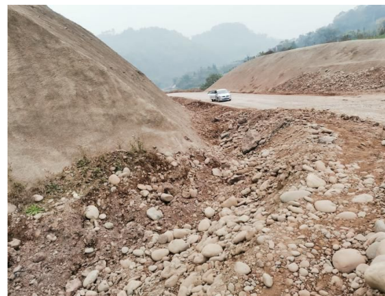
启用的斑竹村弃渣场挡护、表土剥离、临时覆盖、临时排水沟等水保措施
