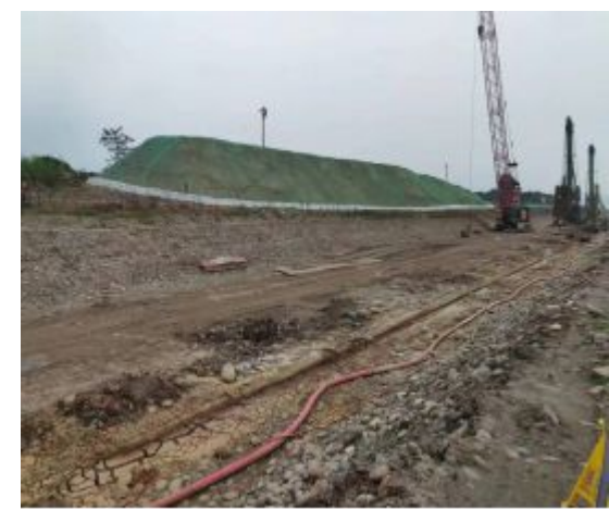
孝姑库区表土剥离、集中堆放、临时覆盖、采取袋装挡护
