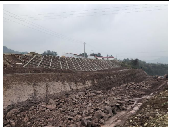
五局拌合楼营地边坡网格护坡
