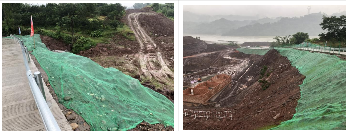
道路边坡临时苫盖处理
