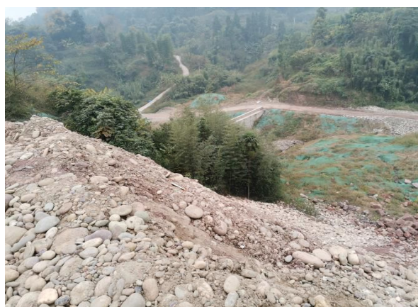
启用的斑竹村弃渣场挡护、表土剥离、临时覆盖、临时排水沟等水保措施
