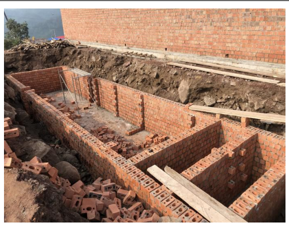
左岸砂石拌和系统营地化粪池
