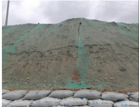
孝姑库区表土剥离、集中堆放、临时覆盖、采取袋装挡护
