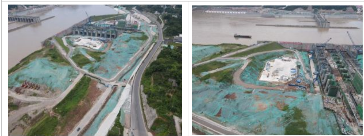
左岸厂房施工区域的临时覆盖、临时排水、临时绿化
