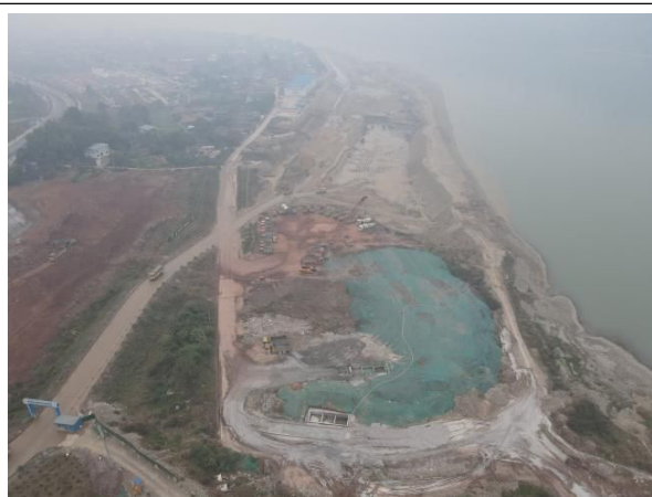
左岸尾水渠施工（临时覆盖）
