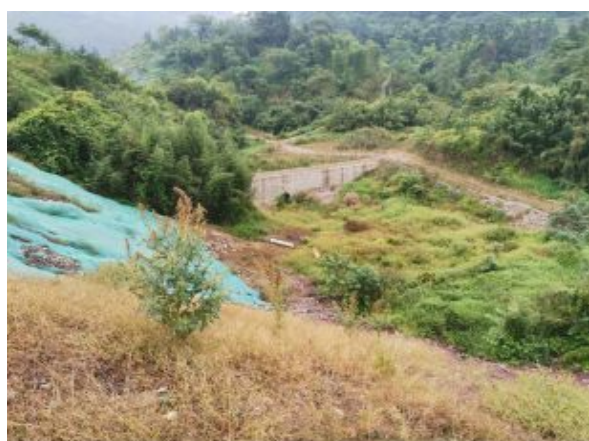
斑竹村弃渣场挡护、表土剥离、排水沟、临时绿化等水保措施
