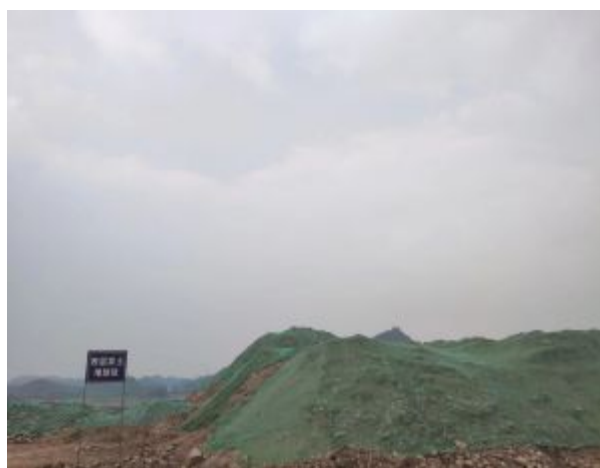
孝姑库区表土剥离、集中堆放、临时覆盖、采取袋装挡护
