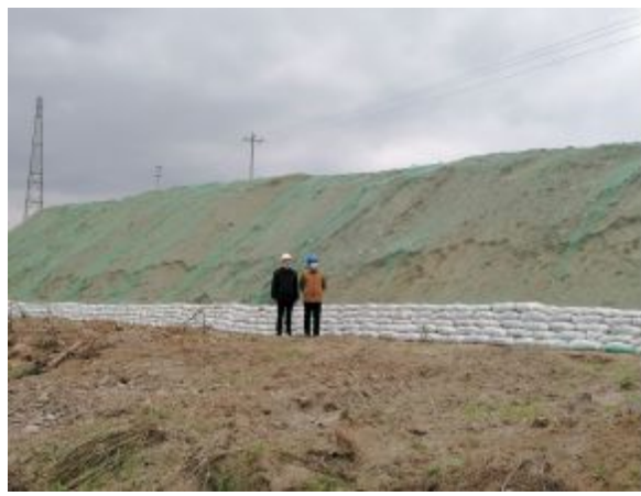
孝姑库区表土剥离、集中堆放、临时覆盖、采取袋装挡护
