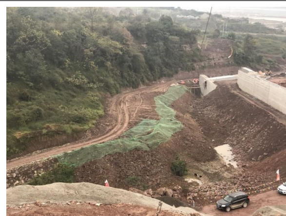
斑竹村渣场施工便道覆盖
