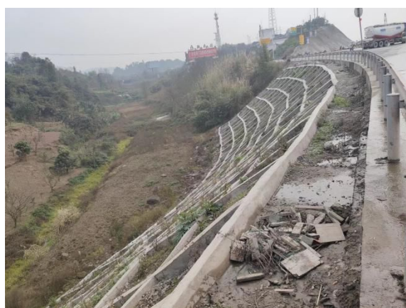
左岸 X144 县道边坡栅格护坡、绿化
