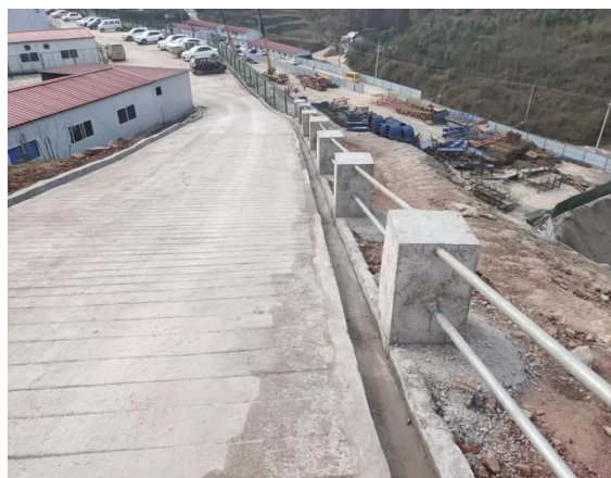
右岸水电十局道路挡护、排水沟
