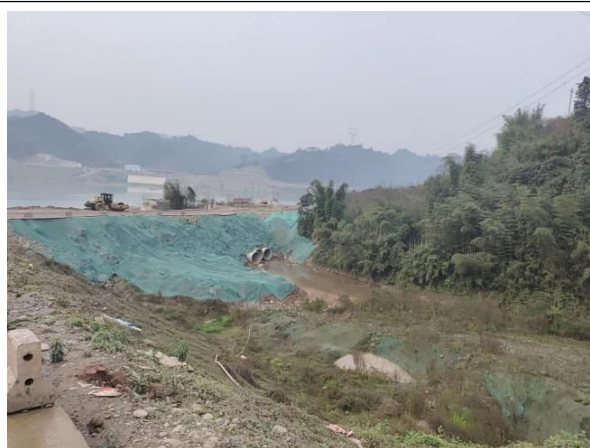
左岸厂房场内边坡覆盖、排水涵管
