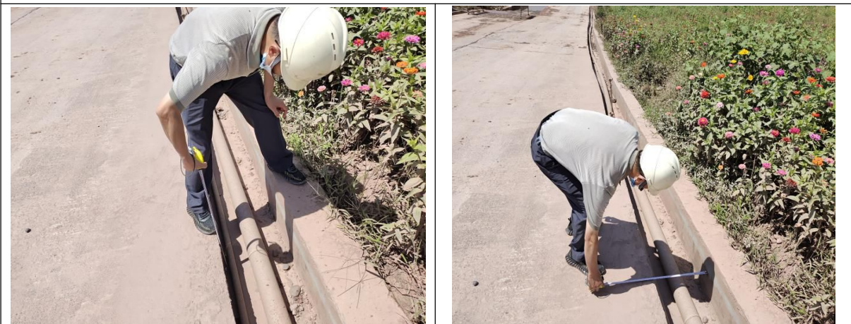
监测人员对左岸厂房排水沟进行测量监测
