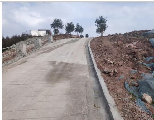
右岸水电十局道路挡护、排水沟
