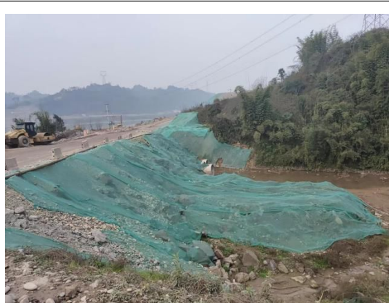
左岸厂房场内边坡覆盖、排水涵管
