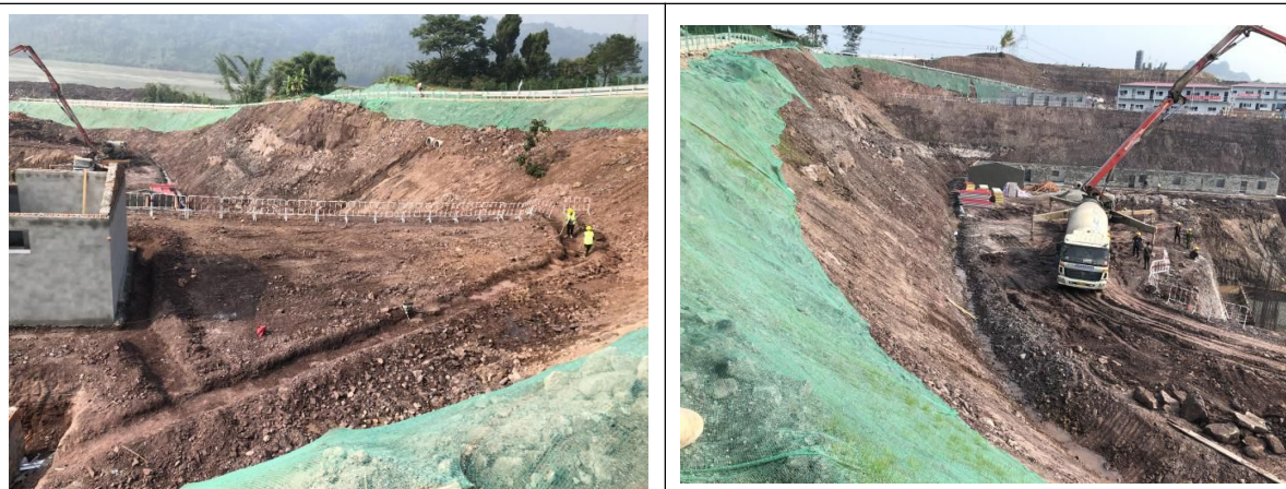
左岸砂石拌和系统办公区临时排水沟
