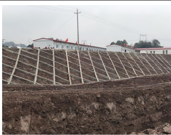
五局拌合楼营地边坡网格护坡
