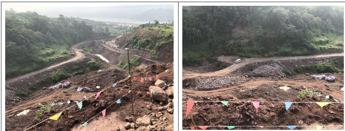
左岸渣场道路正在施工
