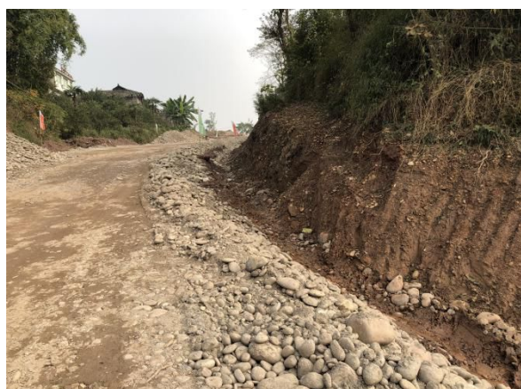
X144 改线 (K0+50) 临时排水沟
