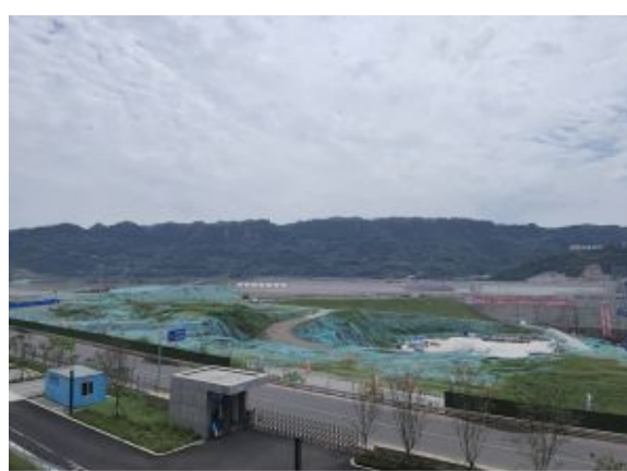
大坝枢纽工程二期围堰内的临时覆盖、临时绿化、临时排水现状
