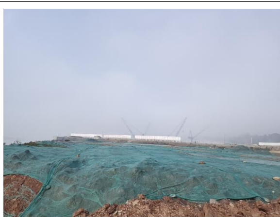
左岸尾水渠施工（临时覆盖）
