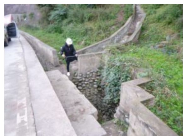
水保监测对右岸 1 井公路排水沟、沉沙池进行监测
