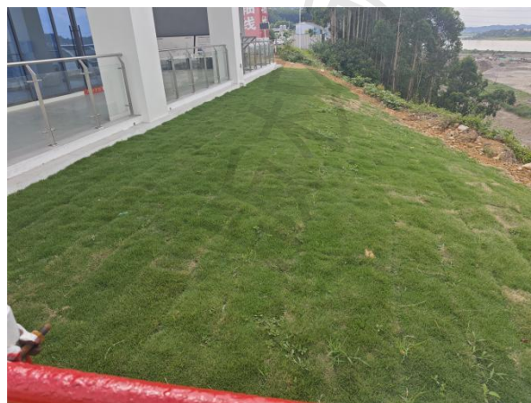
办公生活营地边坡草皮铺设
