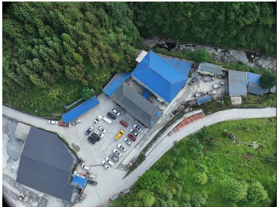
办公区及机修厂等现状
