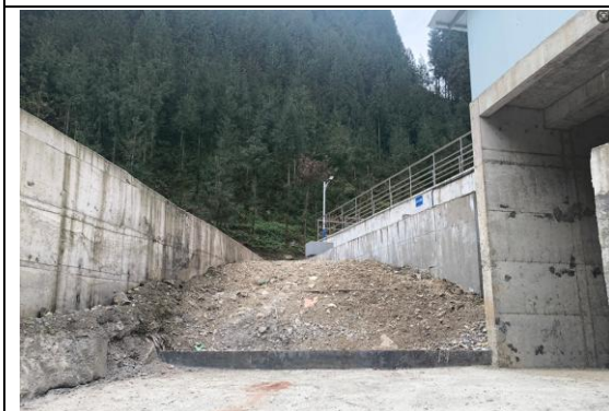
现场裸露地表（2025.3）
