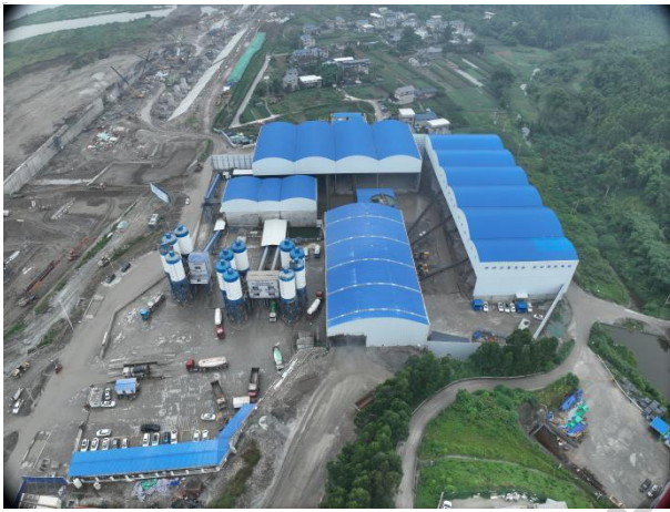
右岸砂石、混凝土系统
