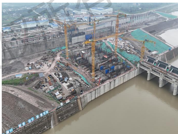
右岸枢纽工程区现状
